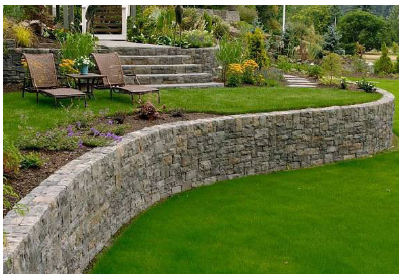
Рис. 1. Монолитная подпорная стена, облицованная искусственным камнем
