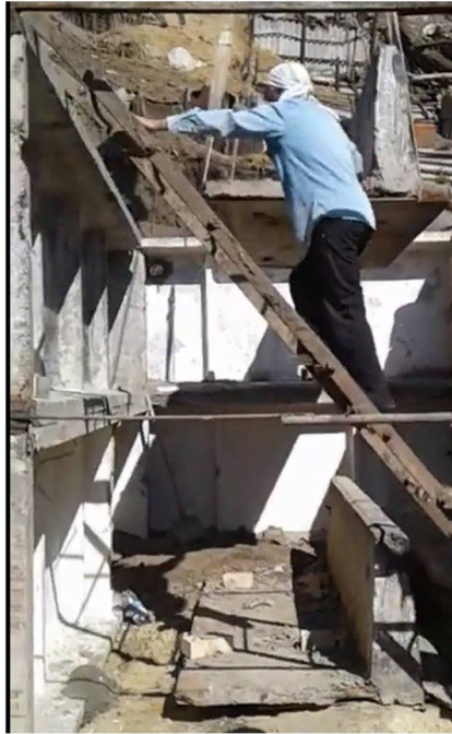
Рис. 16. Осмотр и выбор для повторного использования железобетонных конструкций
