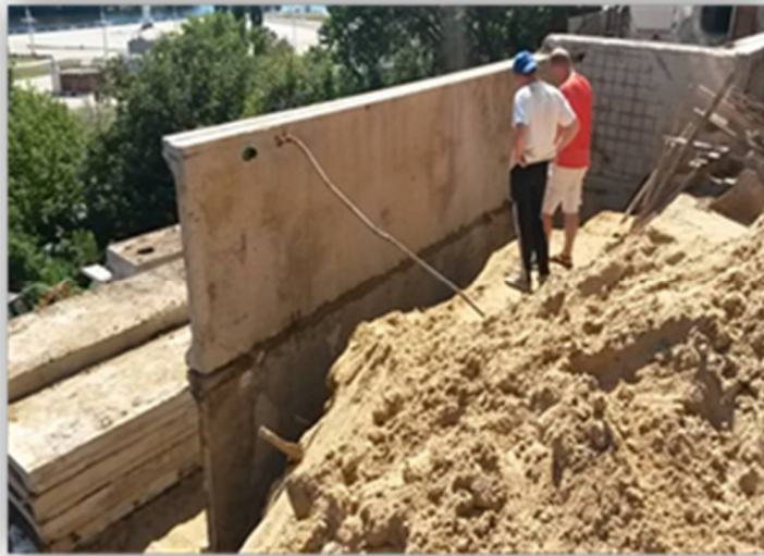
Рис. 17. Повторное использование железобетонных конструкций, при устройстве подпорных стен
