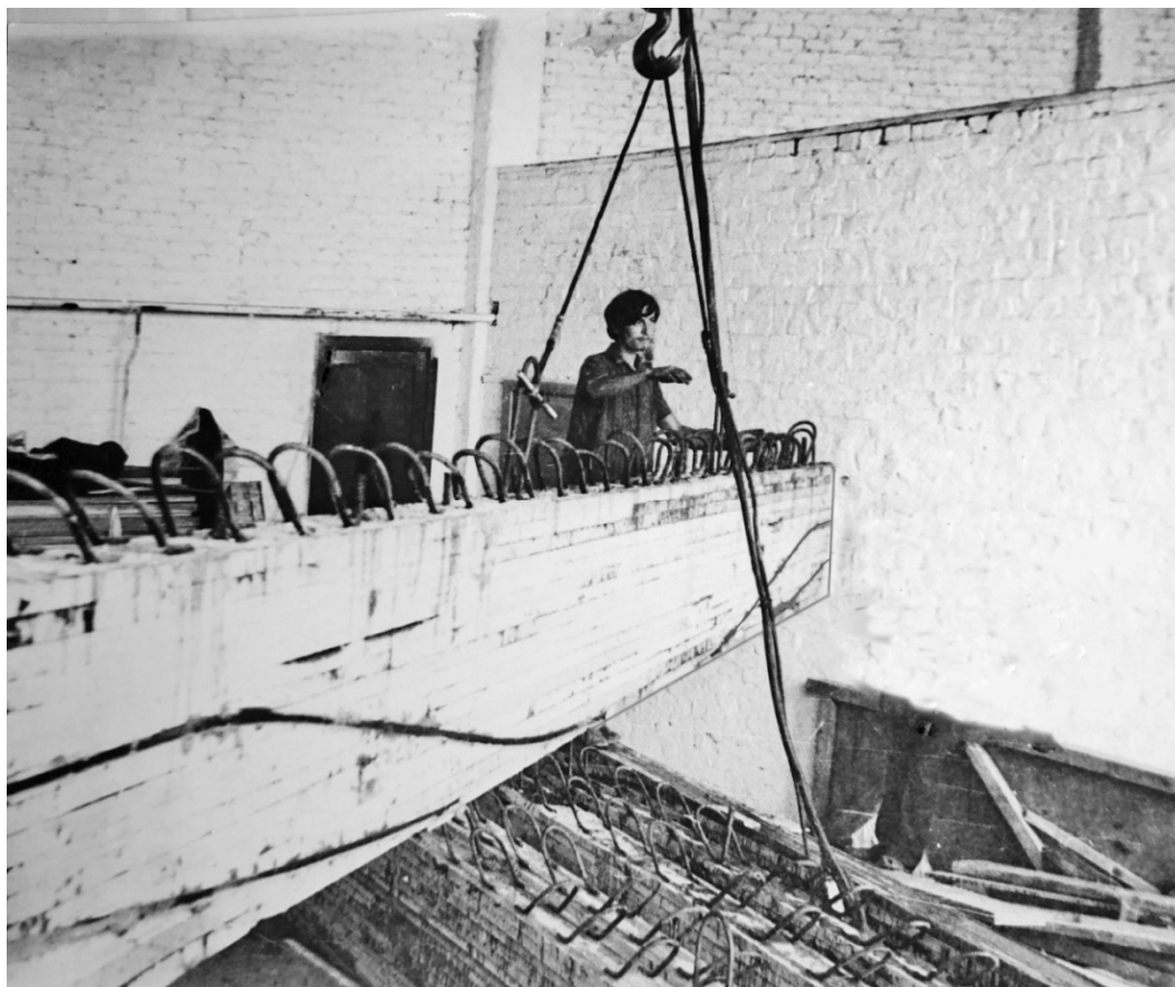
Рис. 1. Клеенные деревянные балки для моста, предварительно напряжённые стеклопластиковой арматурой
