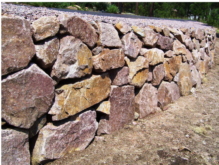
Рис. 3. Подпорная стена из природного камня
