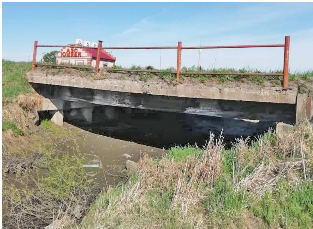
Рис. 6. Современный вид моста в 2020 году
