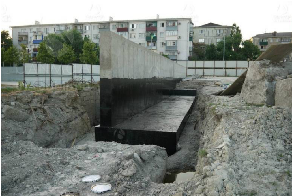
Рис. 6. Подпорная стена из монолитного железобетона
