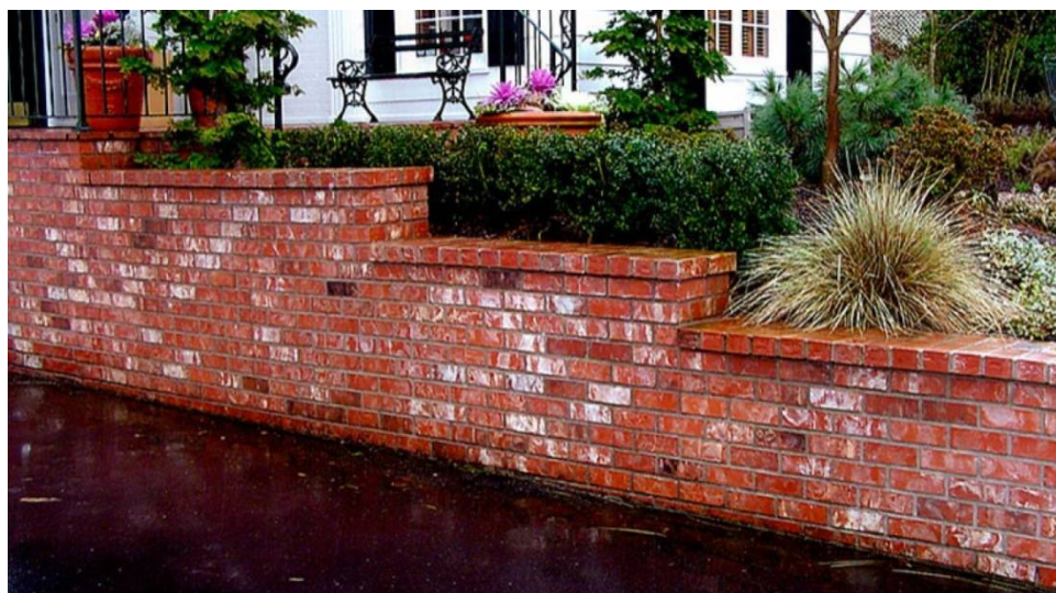
Рис. 2. Подпорная стена из керамического кирпича
