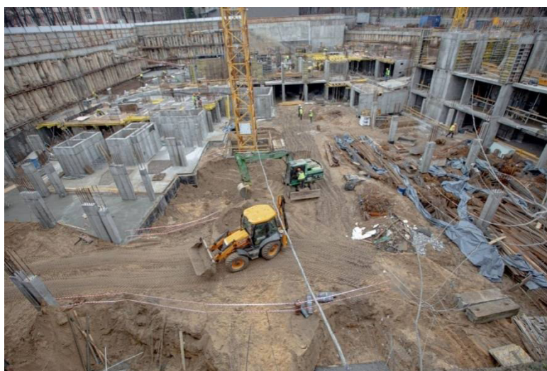
Рис. 12. Устройство подземной парковки плотной городской застройки
