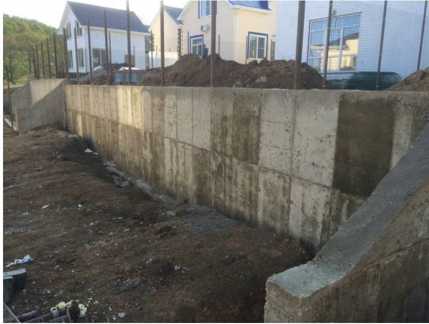
Рис. 6. Подпорная стена из монолитного железобетона
