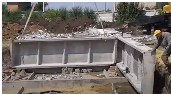
Рис. 9. Подпорная стена из сборно-монолитного железобетона
