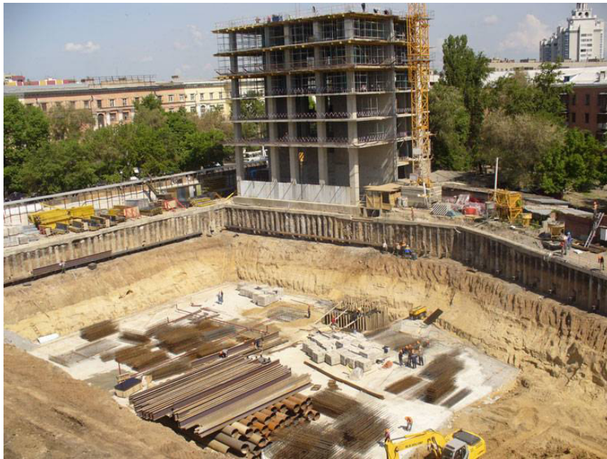
Рис. 13. Устройство подземной парковки в условиях плотной городской застройки
