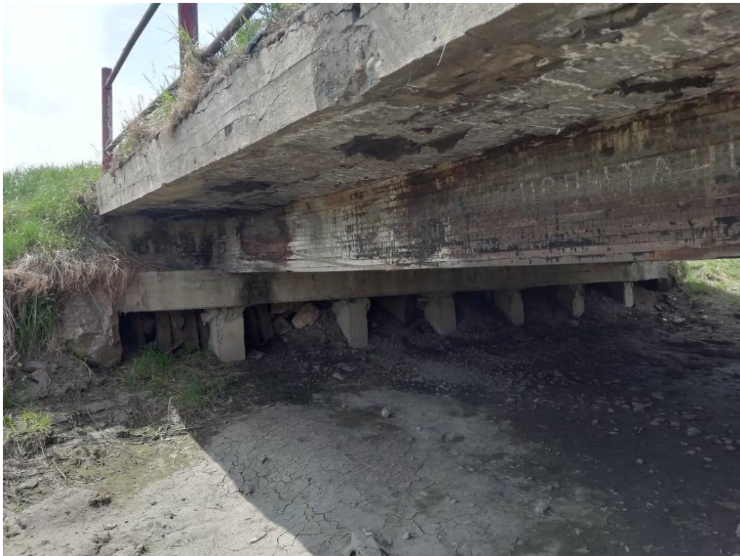
Рис. 7. Общий вид крайней пролётной деревянной балки моста
